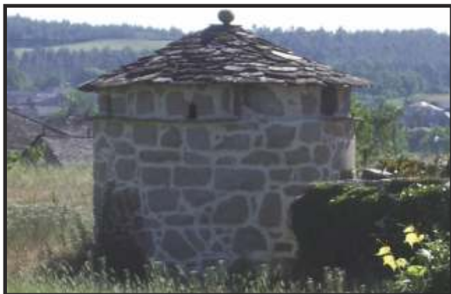
Fig. 4 - Pombal de cachotería de granito
