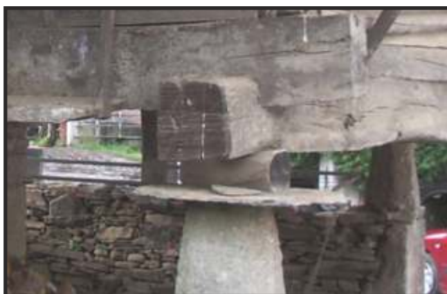
Fig. 14 - Tornarratos sobre columnas
