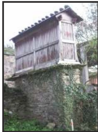
Figs. 10 e 11 - Cepas macizas de cachotería de pedra granítica e de xisto, respectivamente
