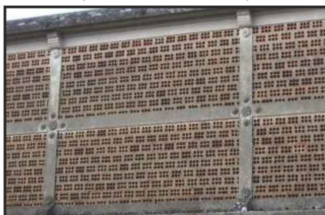
Fig. 18 - Estrutura de formigón e cerramento de ladrillo oco
