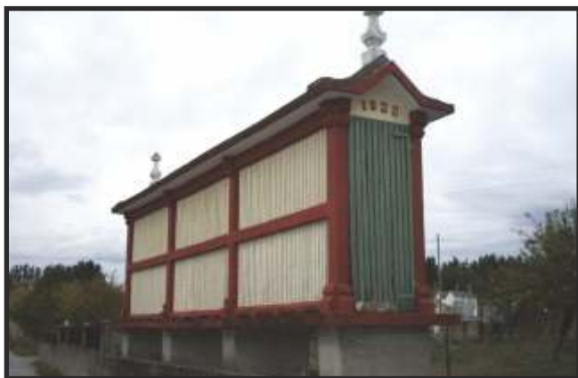
Fig. 37 - Hórreo de formigón sobre cepas
