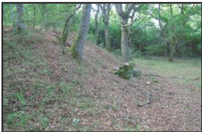
Terraplén defensivo do Castro de Verín
