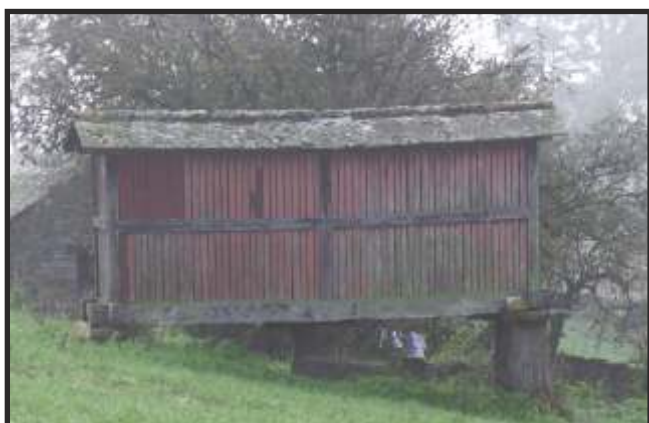
Fig. 26 - Hórreo de madeira e planta rectangular
