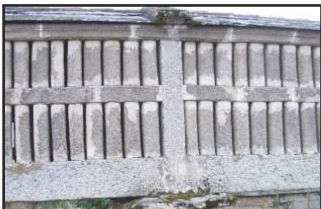
Fig. 16 - Doelas e estrutura de pedra
