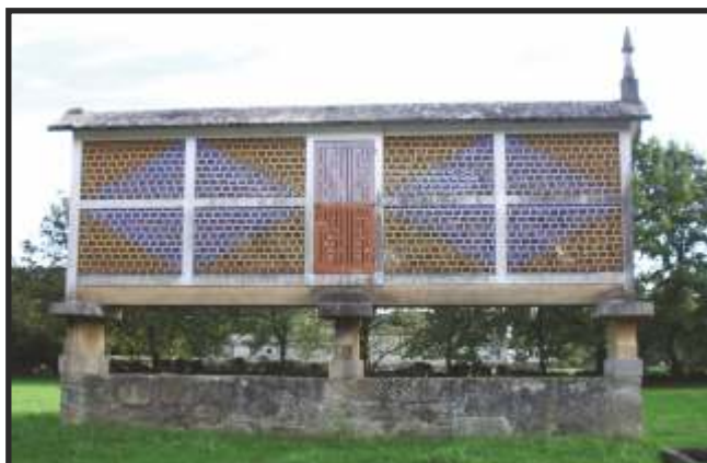
Fig. 36 - Hórreo e albanelería sobre cepas
