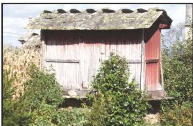
Fig. 25 - Hórreo de madeira e planta rectangular
