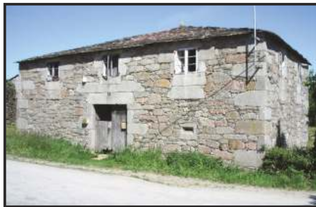
Fig. 2 - Casa de granito
