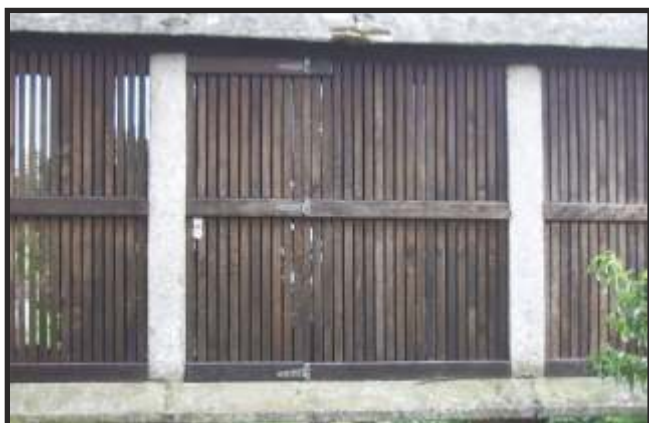
Fig. 15 - Doelas de madeira e estrutura de pedra
