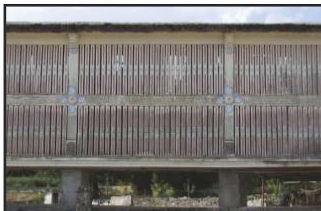
Fig. 17 - Doelas e estrutura de formigón
