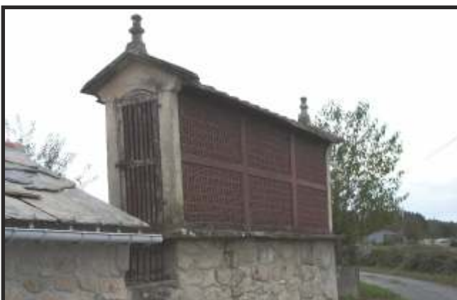
Fig. 35 – Hórreo de albanelería sobre cepa maciza
